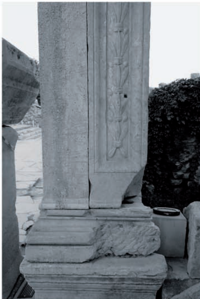
3 Pfeiler 110S , unterer Teil, Ansicht Ost
